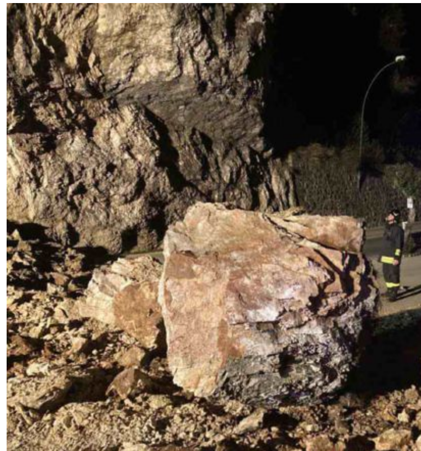
La frana Lo spaventoso masso caduto fuori dall'hotel
